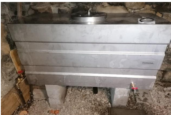
Das Herzstück im Keller, der frostsichere Wassertank. So steht auch im Winter bestes Quellwasser den Gästen zur Verfügung
