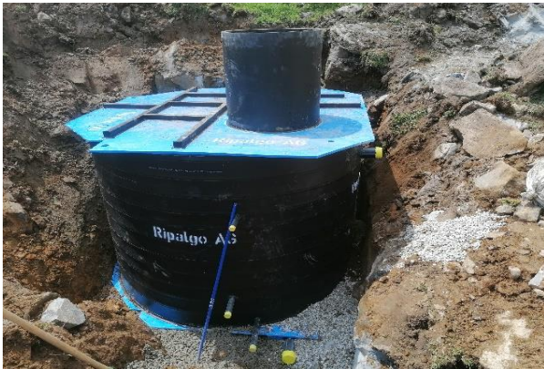
Leitungen werden verlegt, der Sammelschacht wird versetzt und angeschlossen
