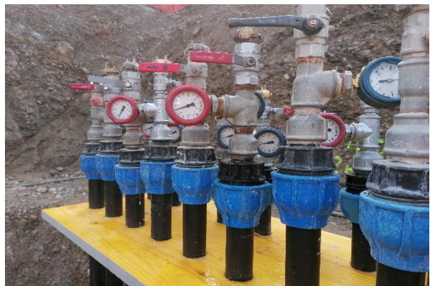
Zwischendruckprüfung und Drucküberwachung während der Aushubarbeiten. Abschlussdichtigkeitsprüfung mit Aufzeichnung und Dokumentation.
