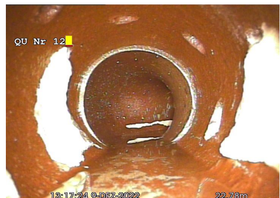
Nachkontrolle, saubere Leitungen mit freiem Abfluss
