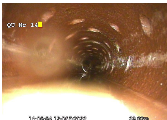
Nachkontrolle, saubere Leitungen mit freiem Abfluss
