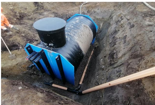
Kombiniertes Bauwerk Reservoir mit Einlaufkammer und Verwurfmöglichkeiten
