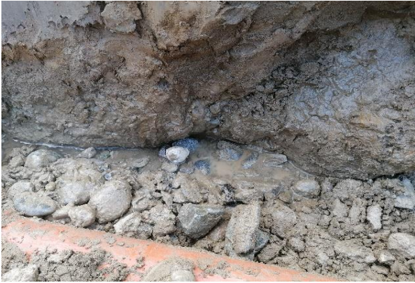
Freilegen der bestehenden Quellsfassung und weitere Vorkommen suchen und ebenfalls freilegen
