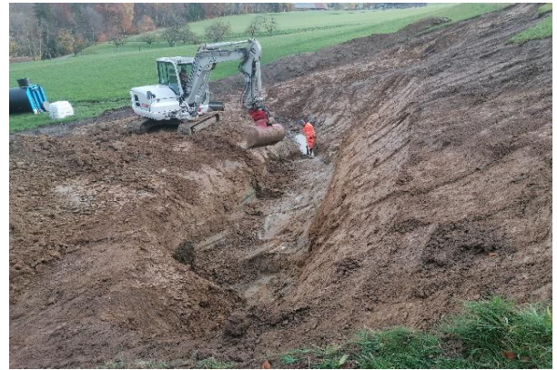
Freilegen der bestehenden Quellsfassung und weitere Vorkommen suchen und ebenfalls freilegen
