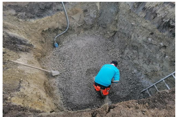
Leitungen verlegen und Reservoir versetzen
