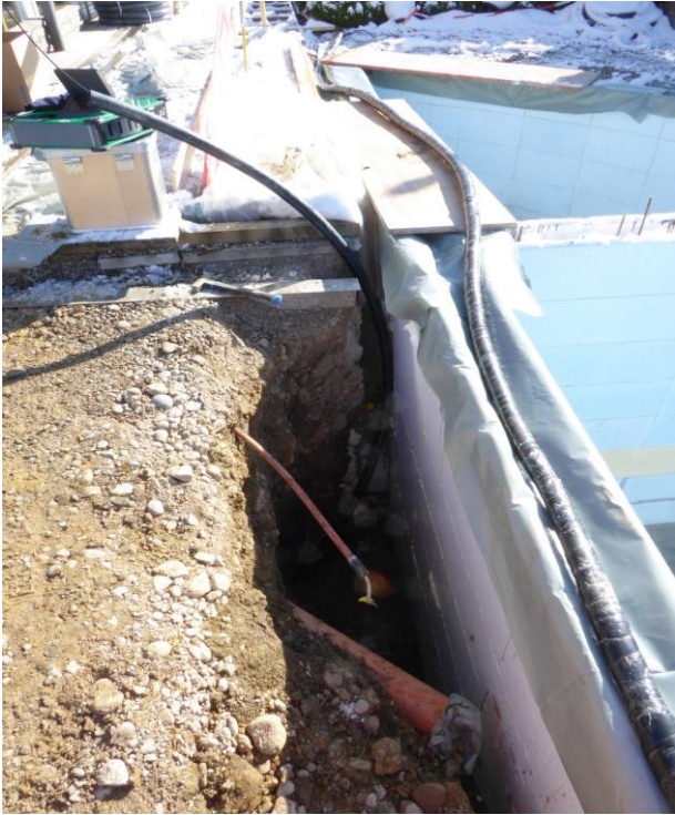
Vorbereitungsarbeiten: Freilegen der Leitung, auch in beengten Verhältnissen möglich.
