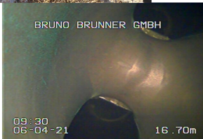
Kameraufnahmen: Mit der Kamera wird in das Rohr gefahren und es können Bild und Filmaufnahmen gemacht werden
