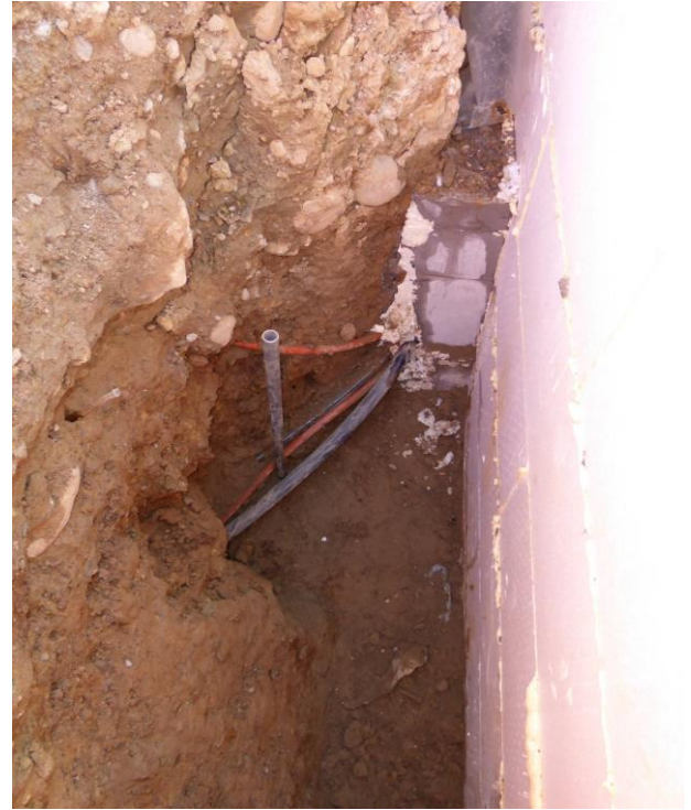
Vorbereitungsarbeiten: Freilegen der Leitung, auch in beengten Verhältnissen möglich.
