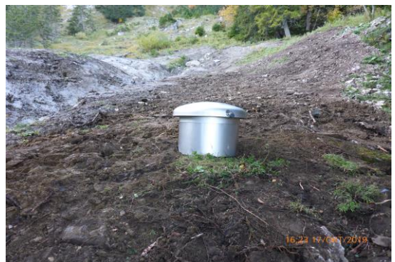
Nach Abschluss der Grabarbeiten.
