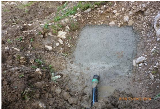
Abschluss der Fassungsarbeiten.
