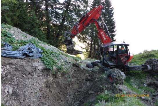
Ausführen der Probegrabungen mit örtlicher Tiefbauunternehmung.
