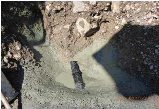
Ausführen der Quellwasserfassungen mit Tonabdichtungen.
