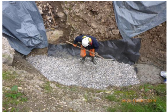
Einbringen der Geröllpackungen.
