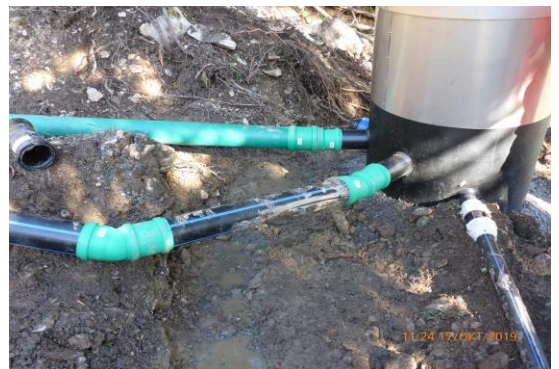
Verlegen der Sammelleitungen und versetzen der Sammelschächte.
