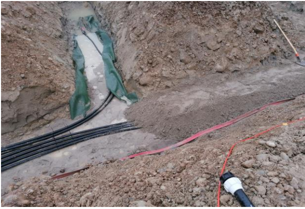
Verschweißen und verlegen der Anbindeleitungen, zum Teil in ungünstigem Untergrund
