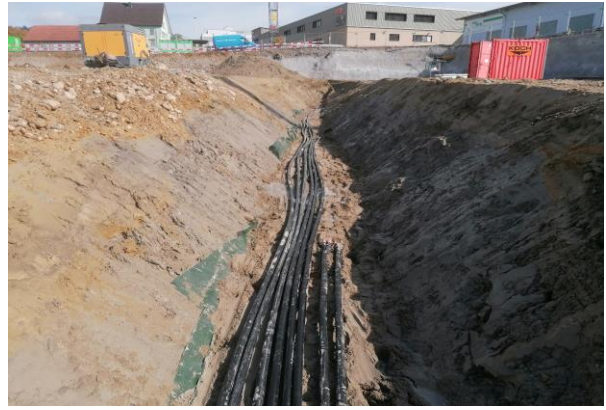
Leitungstrasse in tiefen Gräben
