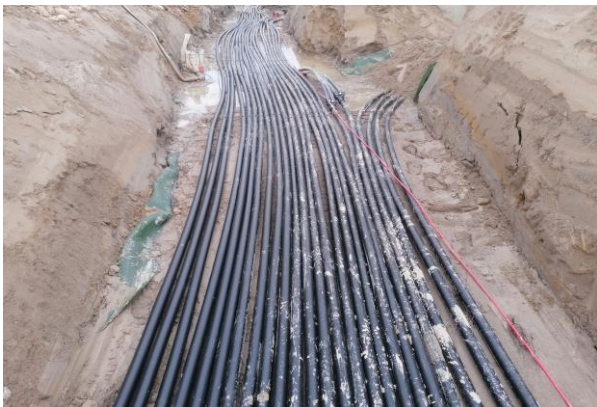
Auf Sandbett verlegte Anbindeleitungen
