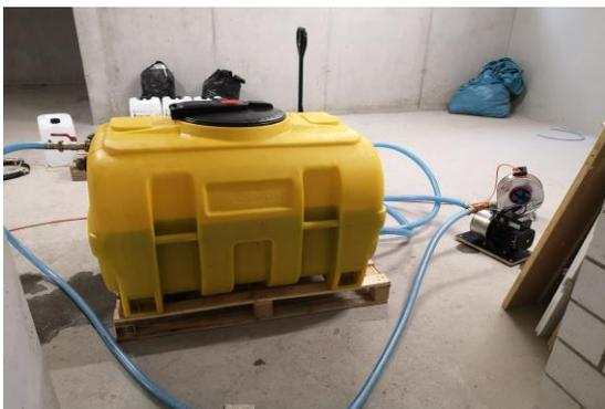
Im Spültank werden die Luftblasen, die sich im Leitungssystem befinden, ausgeschieden.
