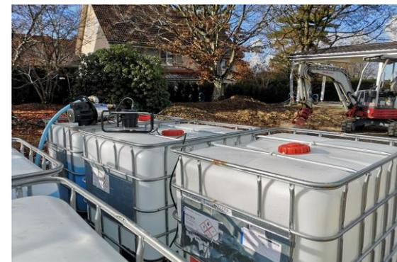
Lager der IBC-Tanks mit Fertiggemisch aus entmineralisiertem Wasser und Glycolkonzentrat.
