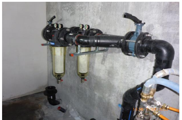
Montage der Wasserfilter im Technikraum
