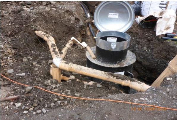
Versetzen der Brunnenschächte
