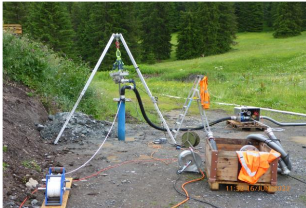
Entsandung und Pumpversuche der beiden Entnahmebrunnen
