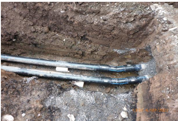
Verlegen und verschweißen von Druckleitungen
