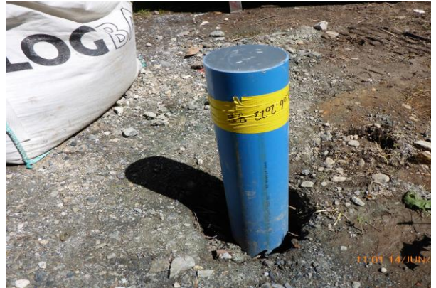
Brunnenrohr bereit zur Weiterbearbeitung
