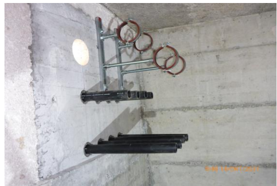
Erdsondenverteiler-Montage
