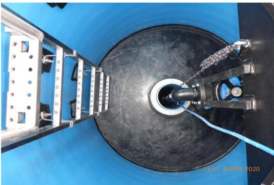
Blick in den fertig montierten Kopfschacht. Im Innern sind alle Steuerungen und Ventile untergebracht.
