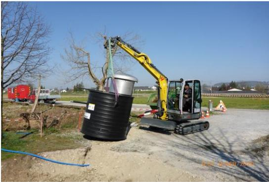
Versetzen des Kopfschachtes, der von uns geplant und in Auftrag gegeben wurde.
