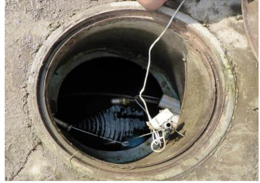
Das alte Reservoir ist in einem ungenügenden Zustand. Die Schachtabdeckung ist baufällig. Die Steuerung im Reservoir ist ebenfalls ungenügend und störungsanfällig.
