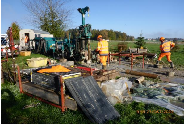
Brunnenbohrung bis in die Tiefe von 31.00 Meter
