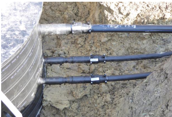
Verlegen von Leitungen und Anschluss an Installationen
