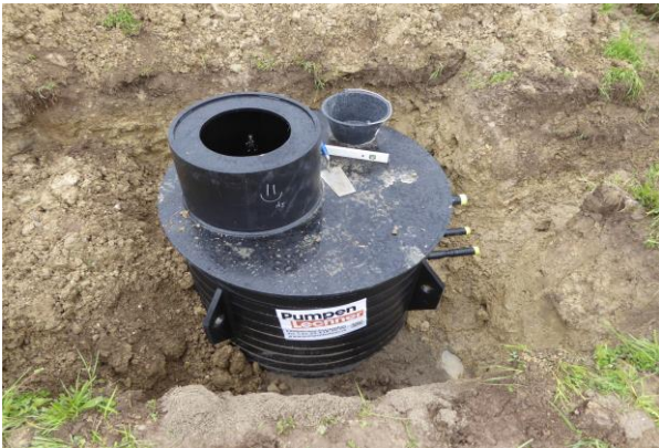
Versetzen des Brunnen-Kopfschachtes
