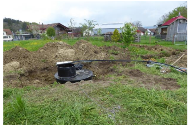
Einbau der Brunnenpumpe
