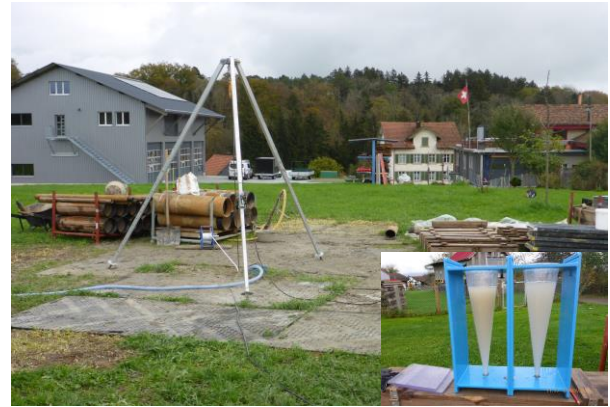
Anschliessende Brunnenreinigung mit Pumpversuch
