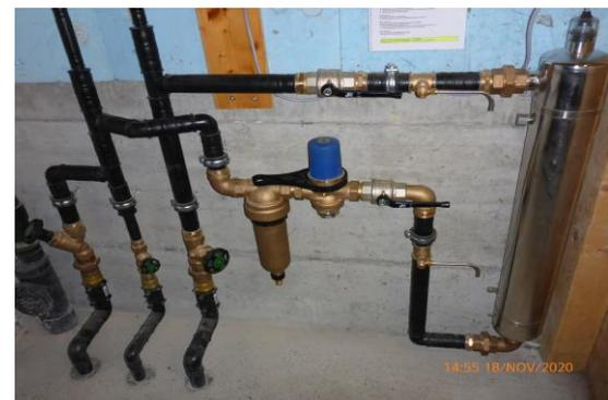
Technikraum mit Hausverteilung, Druckregulierung, UV-Entkeimungsanlage und Wasserfilter.
