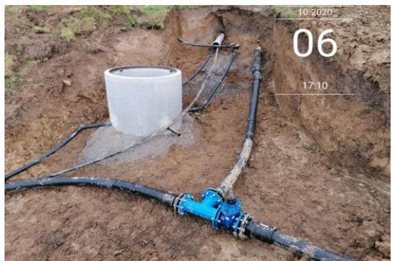
Versetzen der Schachtbauwerke.
