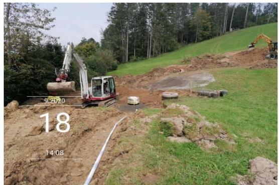
Start der Bauarbeiten, Aushubarbeiten für Pumpschacht und Reservoir.
