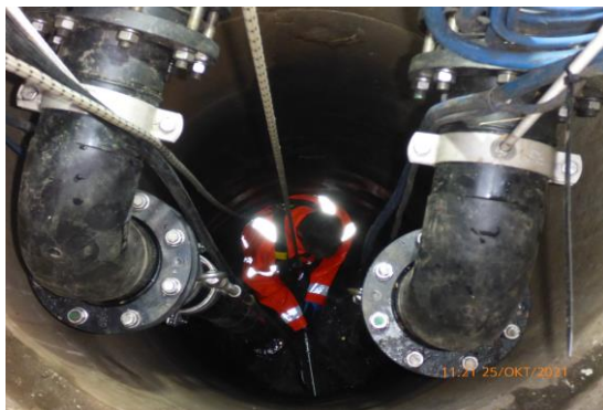
Reinigung mit einer Spüllanze und Hochdruckspülgerät
