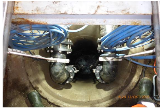
Einstieg in den Brunnen. Eine Person passt gerade durch
