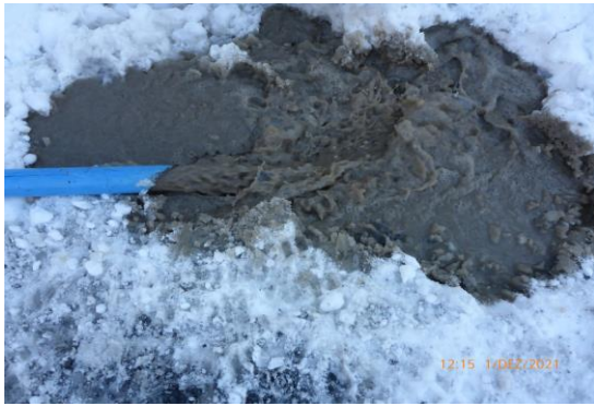
Sandhaltiges Wasser wird abgepumpt
