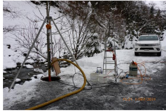
Reinigungsarbeiten im Bohrbrunnen, Baustelleninstallation
