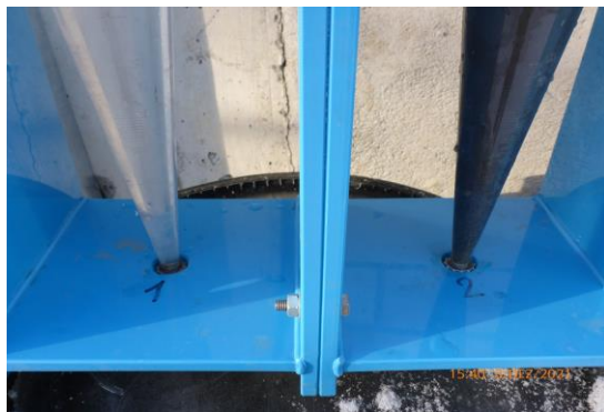
Der Entsandungsvorgang wird so lange weitergeführt bis das geförderte Wasser sandfrei ist
