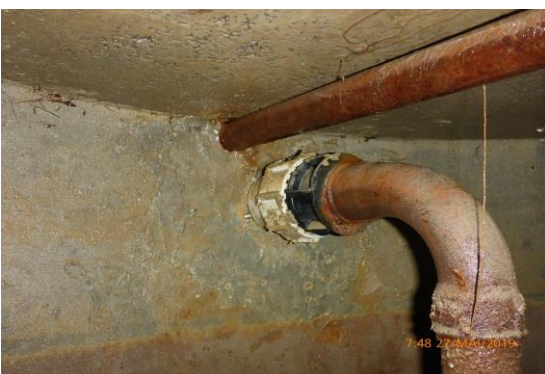
Rostende Metalteile. Sollten durch Chromstahl- oder Kunststoffteile ersetzt werden.
