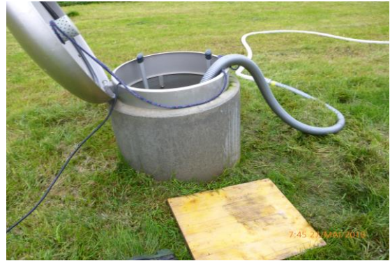
Einstieg mit abschliessbarer Chromstahlabdeckung und Hinterlüftung. Eingebauter Feinstaubfilter.
