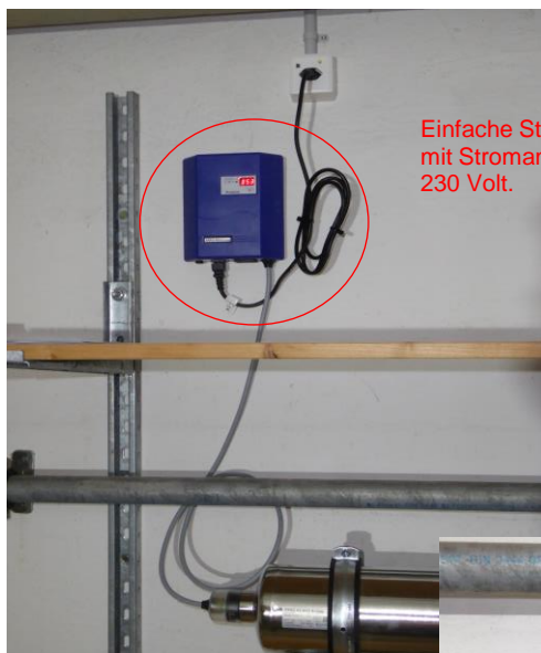
Gesamtansicht und einfache Montage der Ultraviolett-Entkeimungsanlage (UV-Entkeimung)
