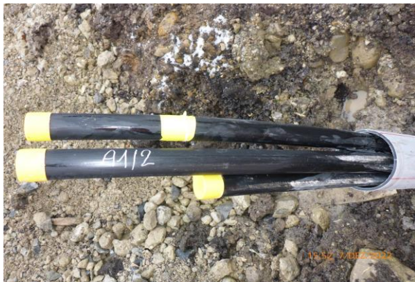
Zur Prüfung vorbereitete Erdwärmesonde
