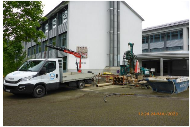
Brunnenbohrung bis in die Tiefe von 27.00 Meter, mit anschließendem Brunnenrohreinbau
