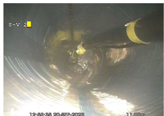
Nach erfolgter Reinigung. In den Brunnenrohren sind die Schlitz wieder sichtbar, Sickerwasser kann ungehindert in den Untergrund abfließen.
