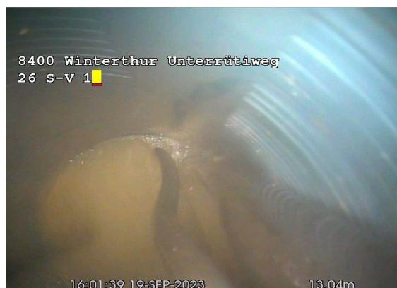
Nach erfolgter Reinigung. In den Brunnenrohren sind die Schlitz wieder sichtbar, Sickerwasser kann ungehindert in den Untergrund abfließen.
