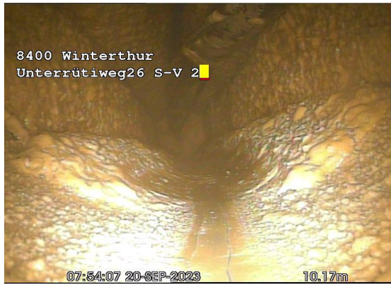
Sehr stark verunreinigte Brunnenrohre mit extremer Verkrustung im Schlitzbereich
