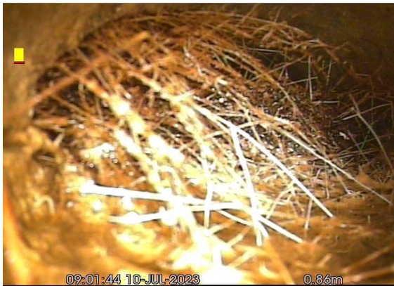
Bestandesaufnahme mit Kanalkamera. Sehr viele Wurzeleinwüchse und verstopfte Leitungen.
